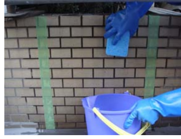
本剤を洗浄箇所に塗り上げる
