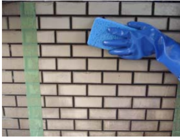
2～3度塗り上げていくと 次第に汚れが落ちます
